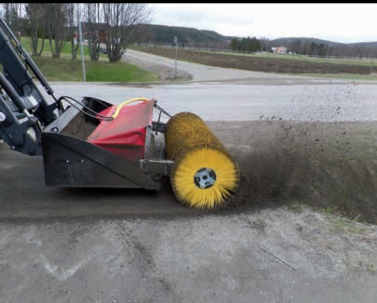
Körning framåt och sopa ut i diket.
